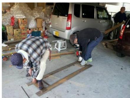
台板の枠づくり
